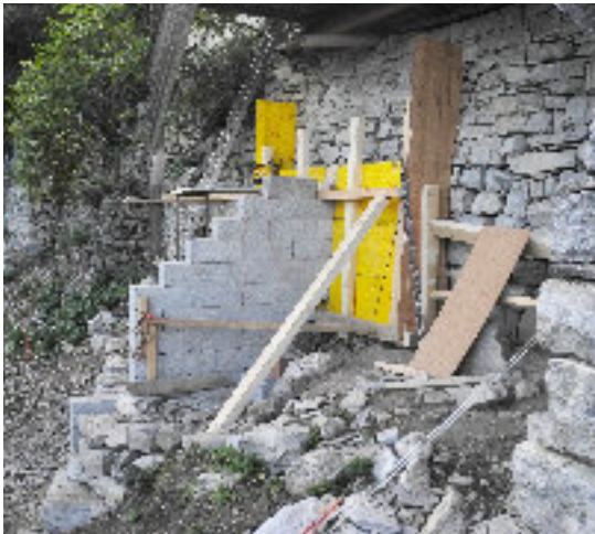
Die bauchende Stützmauer unter der Aussenfütterung wurde mit einer Hilfmauer gesichert.
