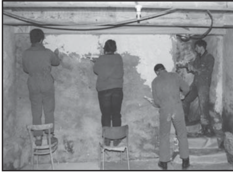
Fleissige Hände beim Weissputz anbringen
