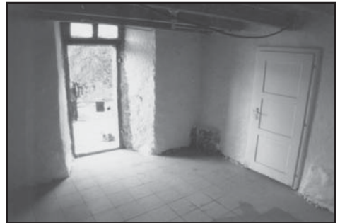
Hell strahlt das Entrée des Lagerteils. An Ostern wurde der Raum neu verputzt,
