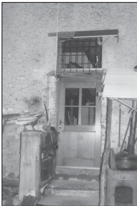
Auch bei den Äplern bläst der Wind nicht mehr durch die Ritzen: Die neue Türe
