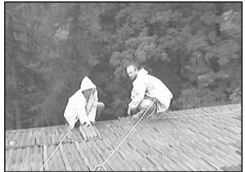
Simon Bächli und Simon Spuhler beim entfernen der vordersten Ziegelreihe
