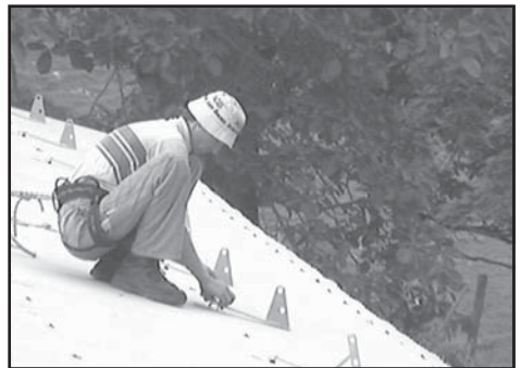
Pius Baumgartner bei der Montage der Halterungen für die Schneesicherungsicherung
