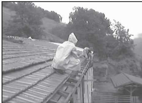
Die dachrinne wird montiert. Wo soll das Wasser durchlaufen?
