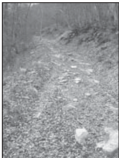
Der Weg - hier das Steilstück oberhalb der Alpe - soll wieder sicher befahrbar gemacht werden
