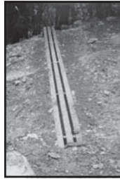
Es wurden ca. 16 Wasserrinnen in den felsigen Untergrund gesetzt
