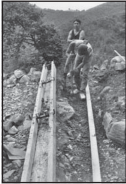
Die Entwässerungs- rinnen werden in den Fahrweg eingebaut
