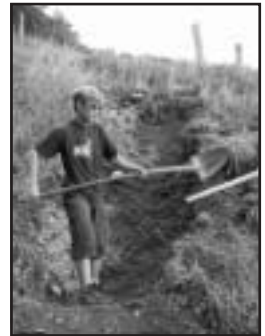
Arbeit am Sondier- stollen für den neuen Wassertank
