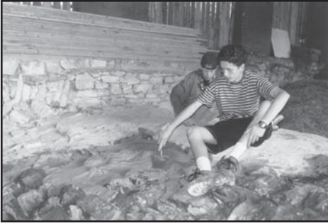
Das Gewölbe muss ausgebessert werden. Es wird mit Beton ausgegossen
