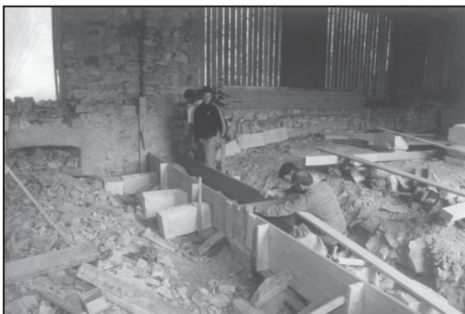
...das Fundament gelegt. Es kann gemauert werden.
