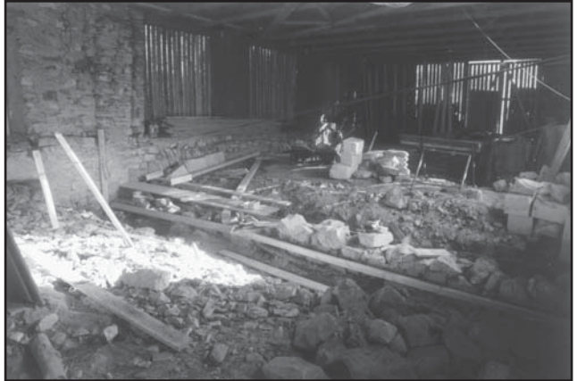
Vorarbeiten Mittelteil: Die Trennmauer zum Heustock ist abgebrochen...
