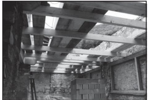
Ein neuer Zwischenboden wird eingebaut.
