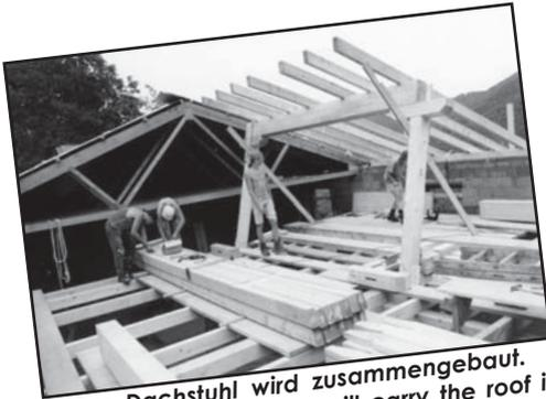
Der Dachstuhl wird zusammengebaut.
