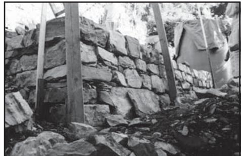
*Mit den Steinen der alten Mauer wird eine neue gebaut (Trockensteinmauer).
