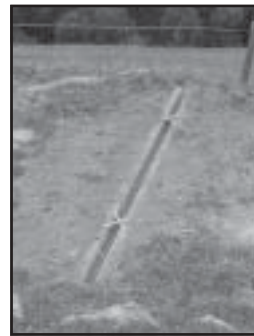
Rinnen wurden gesetzt, um das Wasser aus dem Fahrweg ableiten zu können
