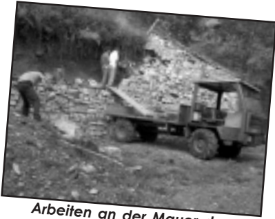
Arbeiten an der Mauer des Unterstandes
